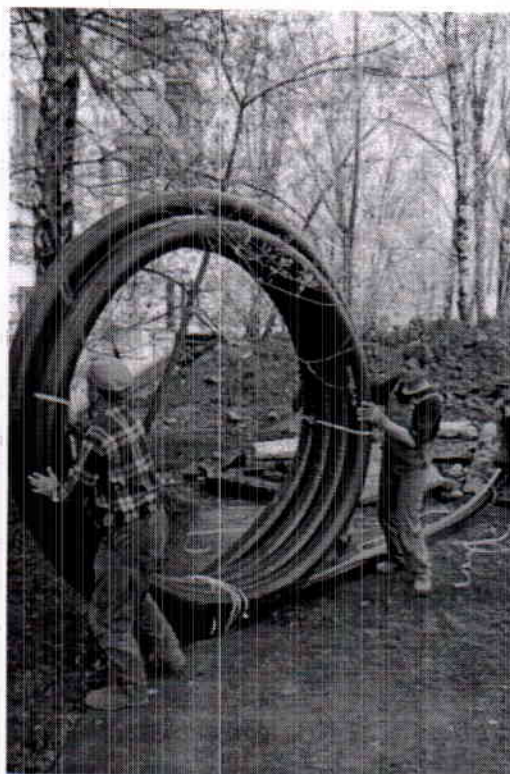
Рисунок 4.4 – Размотка труб ГПИ, поставляемых в бухтах
